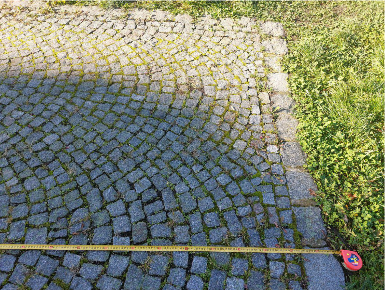
Příklad stávajícího chodníku z žulových kostek 4/6 do vlaštoky, nové chodníky u SO 02 – FARNÍ ZAHRADY, VRCHNÍ ČÁST budou provedeny stejným způsobem.
